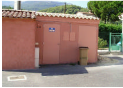
Cabine en bord de chaussée ou près d'un abribus
