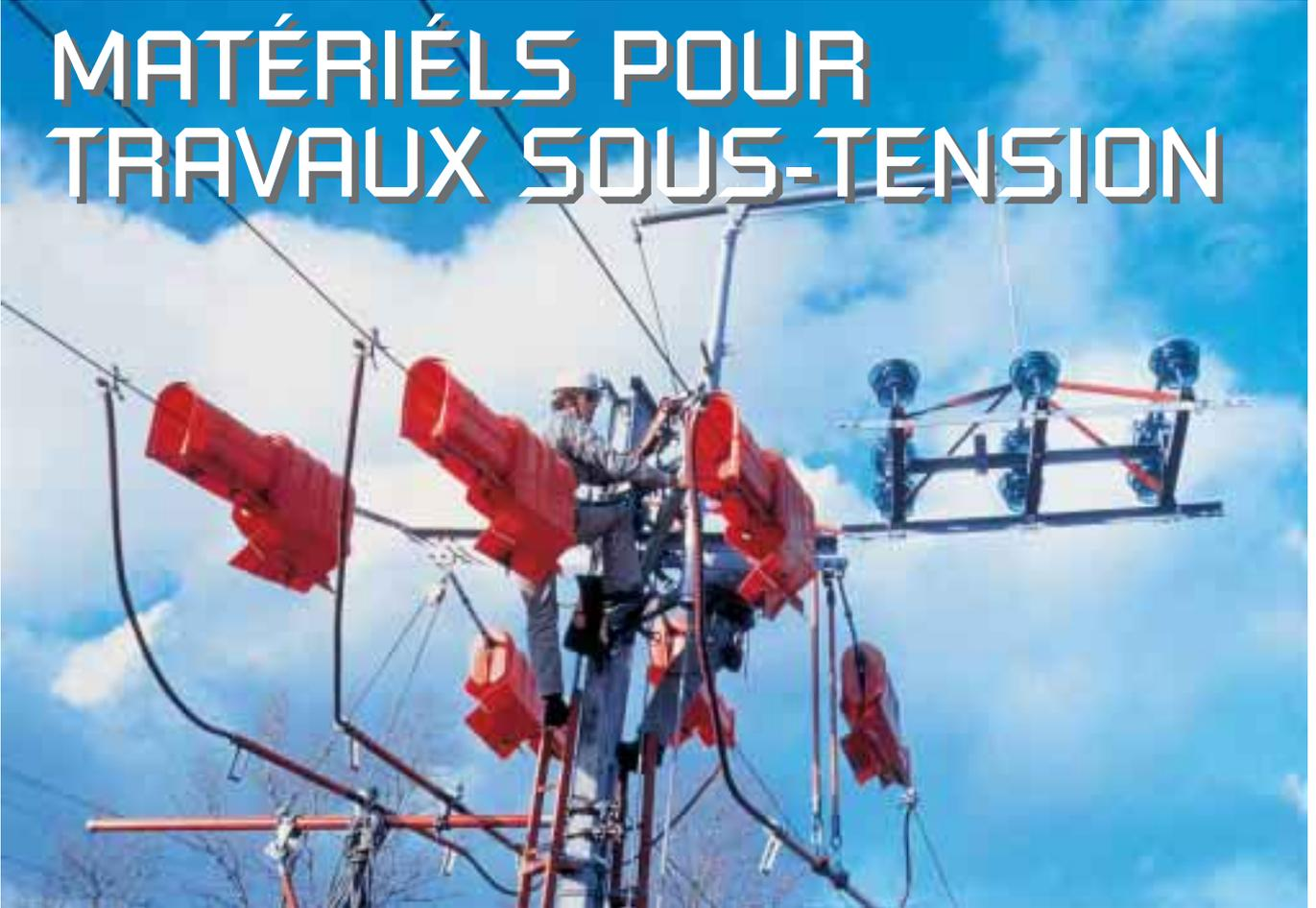
La pratique du travail sous tension nécessite un ensemble d'outils et d'instruments répondant à des caractéristiques précises de tenue mécanique et d'isolement définies par les normes UTE 520 et IEC.
