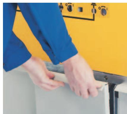
Couverture de compartiment de raccordement de câbles amovible
