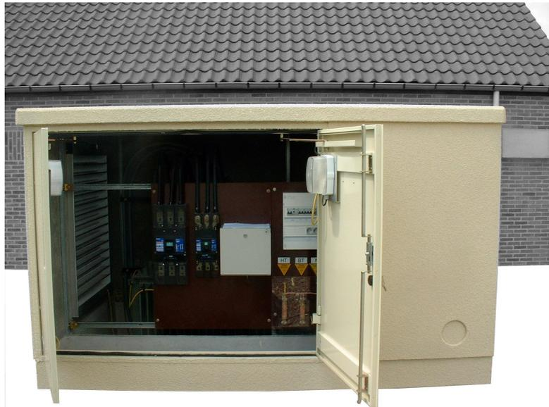
■ Les teintes standards sont le beige (RAL 1015) et le vert olive (RAL 6003). D'autres teintes suivant nuancier peuvent également être obtenues en option. Les faces intérieures des panneaux sont en finition béton lissé non peintes.
